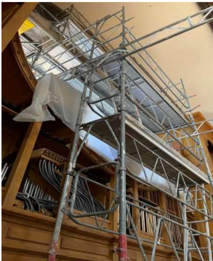
Les échafaudages au-dessus de l'orgue
