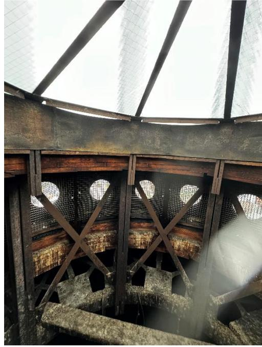
Ce volume est éclairé par une verrière supérieure à la base du clocheton et par des hublots disposés tout autour qui sont fermés par une double épaisseur de grillage contre les intrusions de pigeons.
