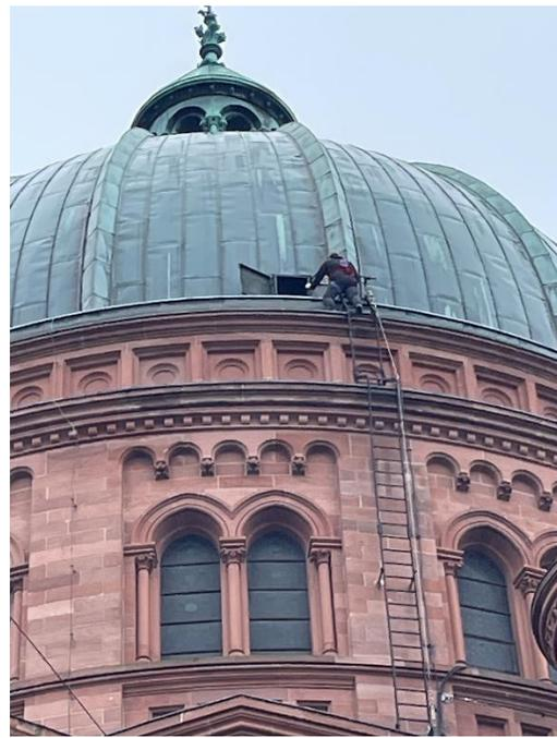
A la base de la coupole un portillon en tôle cadénassé interdit les intrusions de pigeons et autres volatiles.
